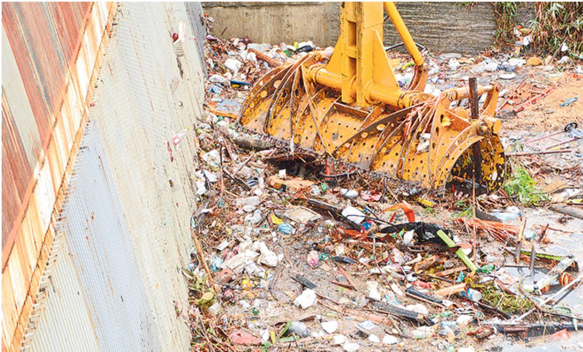
También, para reducir los riesgos de inundaciones, EMCALI efectúa la limpieza de 718 estructuras de separación, las cuales evitan que se mezclen las aguas residuales y las aguas lluvias, evitando que se contaminen los canales por represamientos causados por la acumulación de basuras y demás desechos urbanos.
