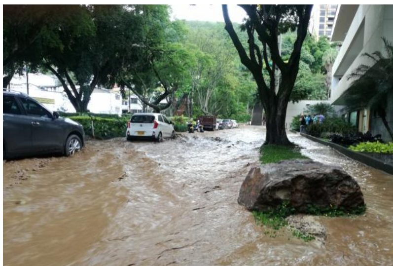
Quebrada Santa Mónica se desbordó en el norte de Cali.
